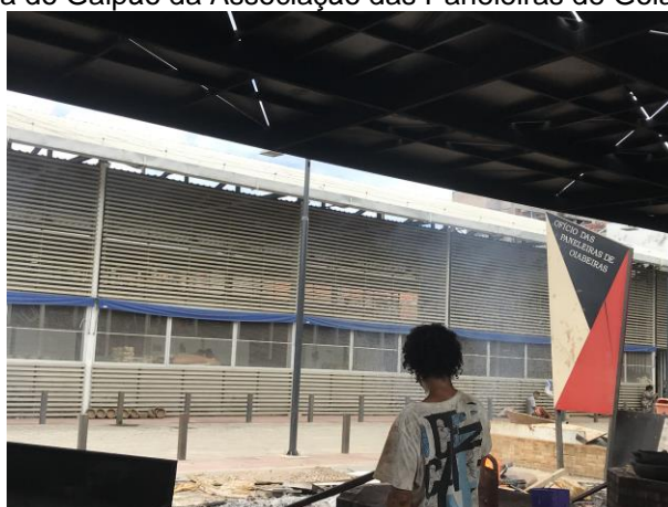
Figura 11: Galpão – vista lateral - da Associação das Paneleiras de Goiabeiras, Vitória/ES.
