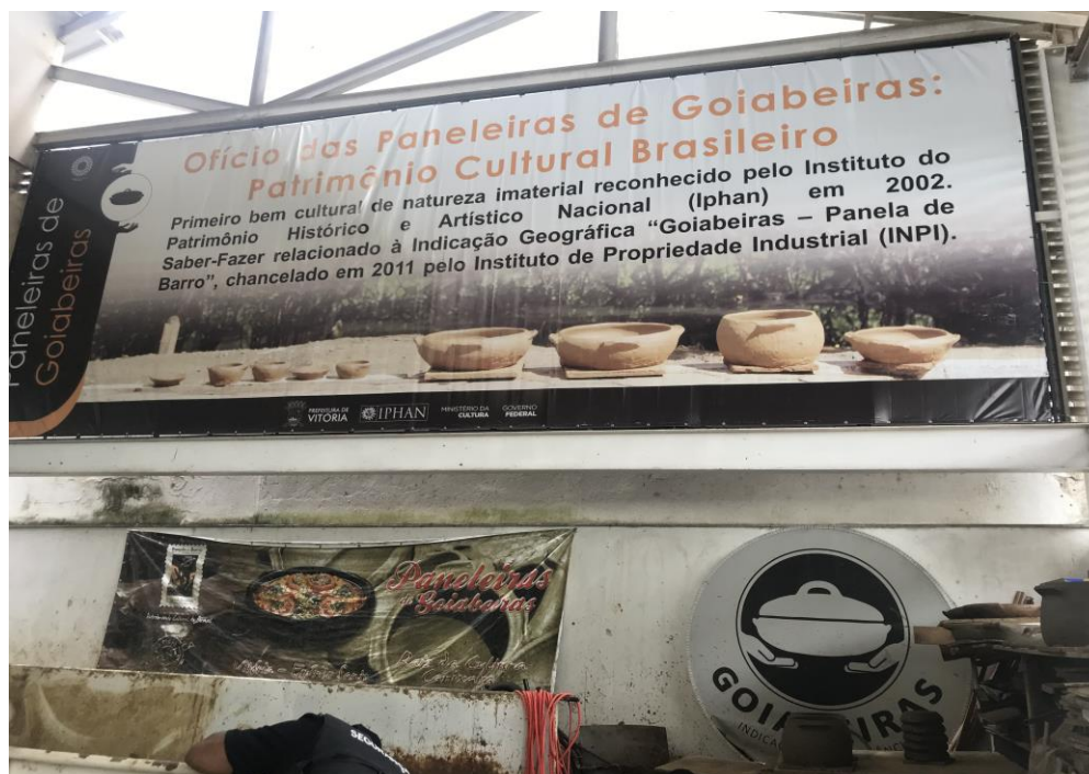
Anexo 09 - Parede dos fundos do Galpão da Associação das Panelas de Goiabeiras, Vitória/ES, acima do local onde fica acondicionado o barro extraído do “barreiro” e que será utilizado para a fabricação das panelas.
