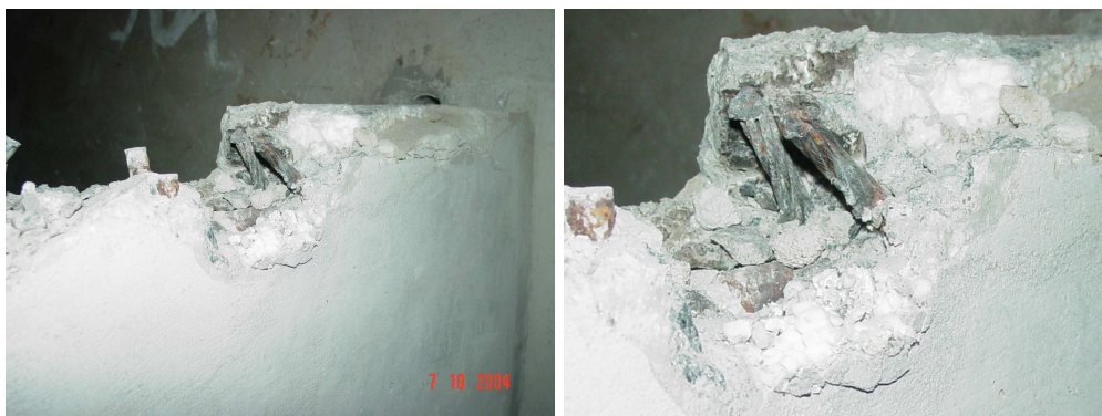
(paredes de dentro das celas do PSMA 68 , com isopor)
