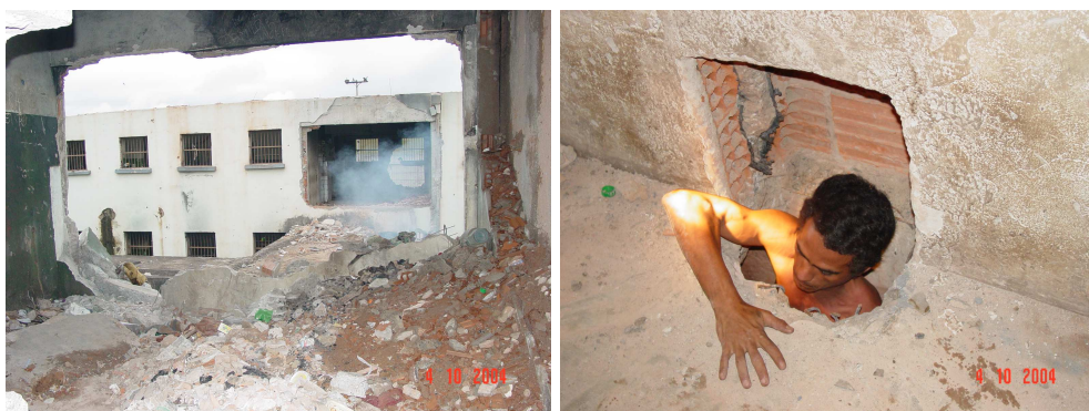
(parede derrubada e preso dentro do túnel na CASCUVI)
